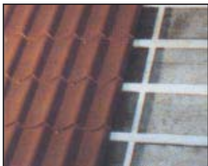
rénovation sur bardeau d'asphalte ou revêtements bitumeux
